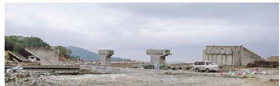
写真-1 ポステンT桁が流失した橋梁
