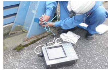
写真-3 超音波探傷状況（H断面フランジ）
