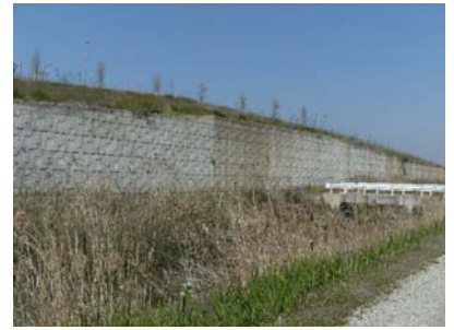
写真-2 補強土壁
