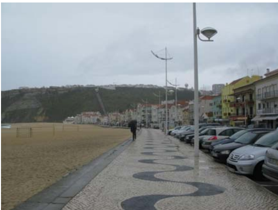
写真-7 市街地の海側に延びる道路、駐車場、遊歩道、砂浜
