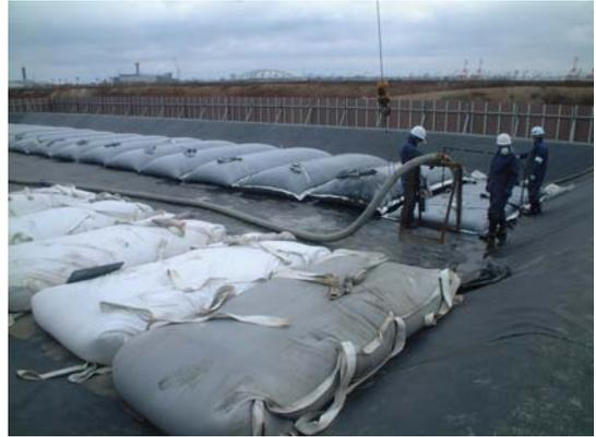
写真-6 施工性の確認試験の状況
