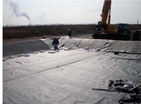
写真-2 充填ヤードの造成状況
