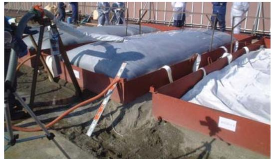
写真-3 鋼製の仮設台での充填状況
