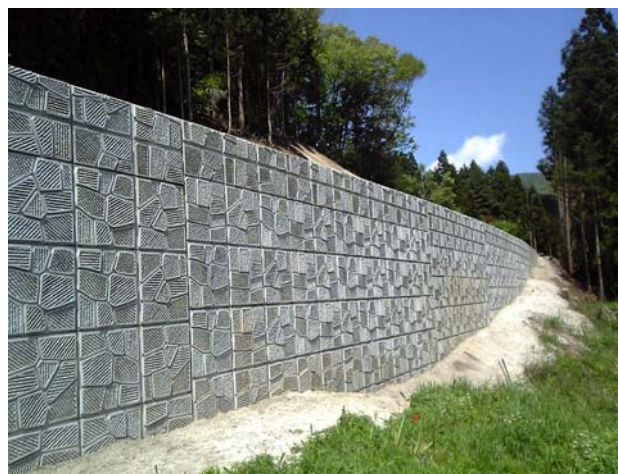
写真-1 現場写真例
