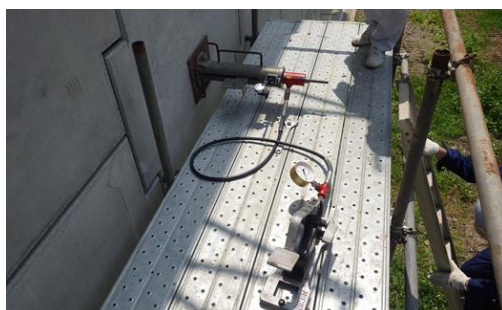
写真-3.1 ストリップの引抜き試験
