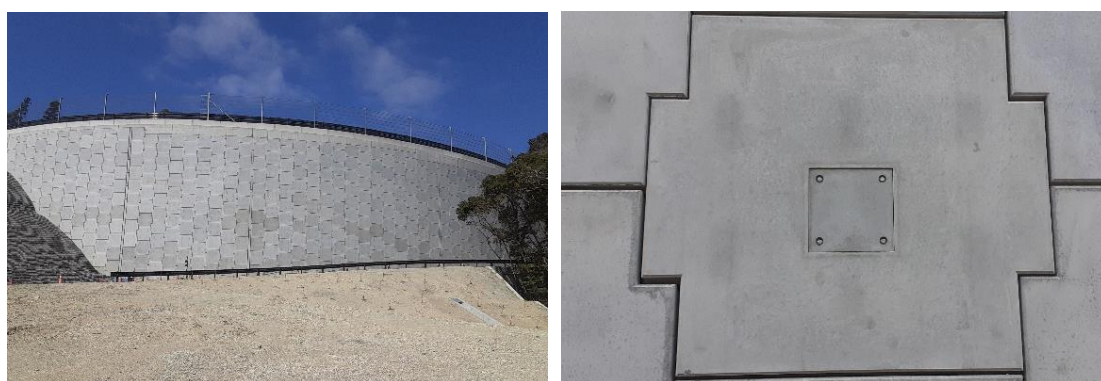
写真-5.2 千葉県 コンクリート蓋式
