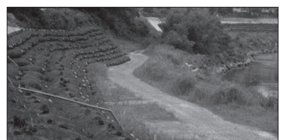
図-1 護岸工としての使用例
