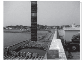
施設 | 急勾配砕石層の構築
