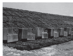
災害復旧 | 決壊堤防の応急対策
