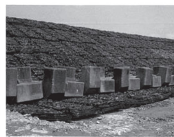
災害復旧 | 決壊堤防の応急対策
