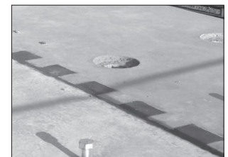
▼間詰めモルタル充填完了
