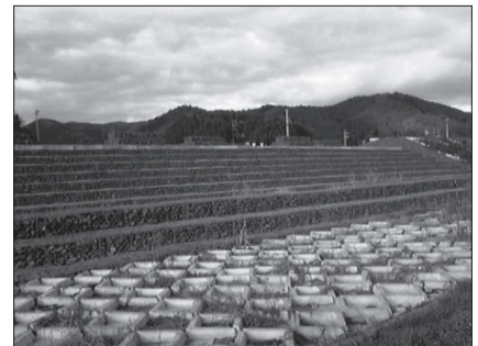
階段式かごマット越流堤
