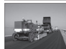
路面加熱状況(舗装接着用)
