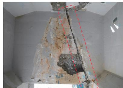
写真-5 横桁の目開き、ずれ
