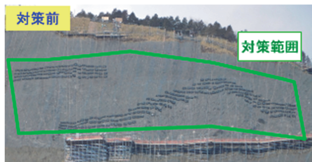
写真-3 崩壊地頭部の対策状況
