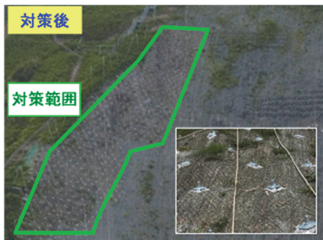
写真-2 ラウンディング部熊本側側部の対策状況
