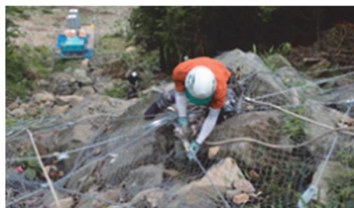
写真-4 ガリー浸食箇所の実施対策工法（ロープ伏工）
