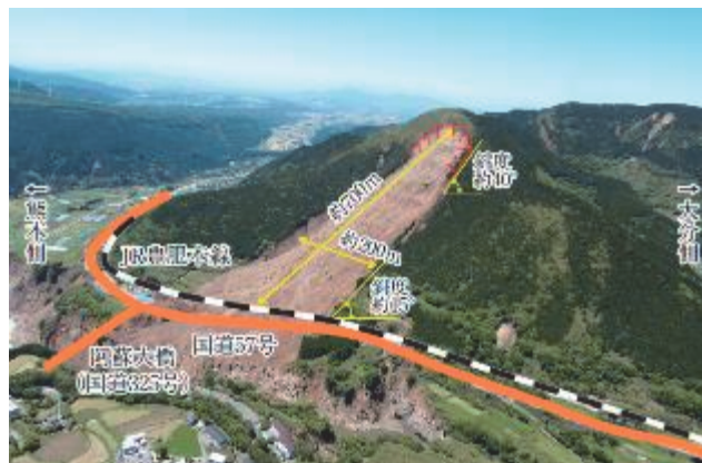
写真-1 阿蘇大橋地区の被災状況
