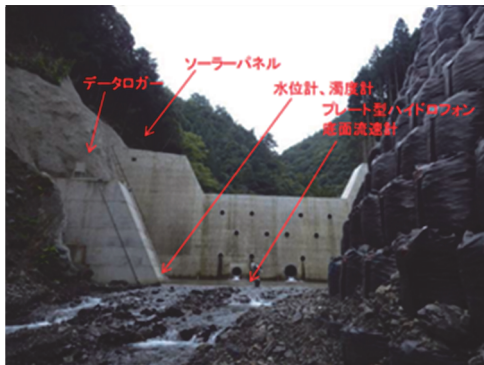
写真-4 砂防堰堤下流での観測機器の設置状況
