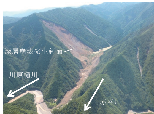
写真-1 災害直後の奈良県五條市の赤谷(あかだに)地区の深層崩壊(平成23年9月6日撮影)
