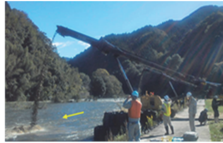
写真-1 ベルトコンベアによる土砂供給状況
