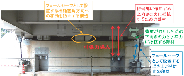
写真-3 A2側支承部の構造
