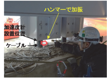
写真-4 A2橋台支承部に設置された上向き反力に抵抗させるPCケーブルの加振状況
