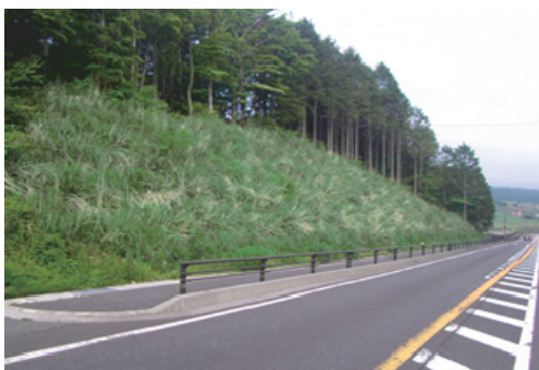
写真-2 国立公園内の道路のり面における施工事例
