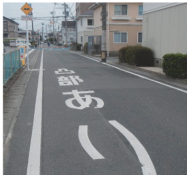
写真-8 路面表示
