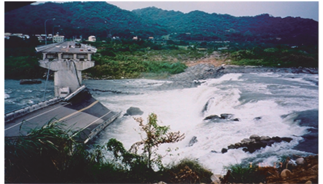
写真-1 地震断層による落橋と河床の段差の発生 1)
