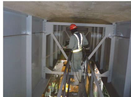
写真-4 高圧洗浄
