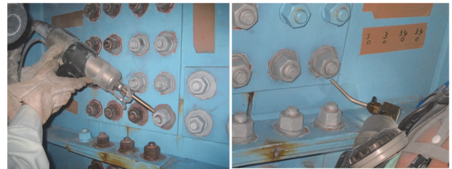
a) 施工状況①
