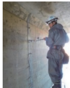
高圧注入工法C（無機系材料）
