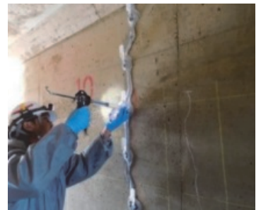
低圧注入工法（エポキシ樹脂材）
