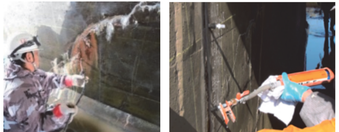
高圧注入工法A（疎水性ウレタン）
