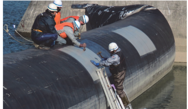
図-2 袋体補修の様子
