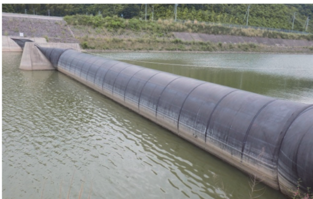
図-1 ゴム堰全景
