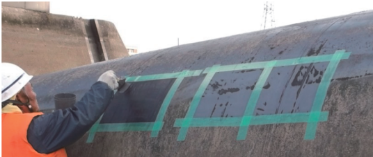
図-9 塗料型補修材の施工例
