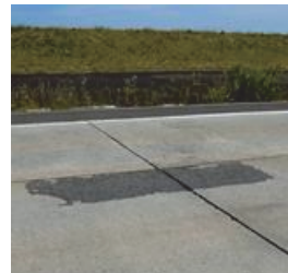
写真-1 局所的な補修事例
