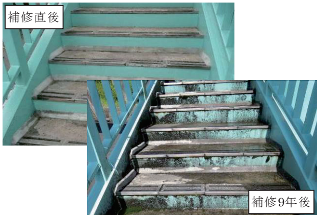
写真-4 階段部補修後の状況
