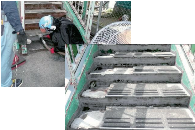
写真-11 階段部 補修状況 (バキュームブラスト)
