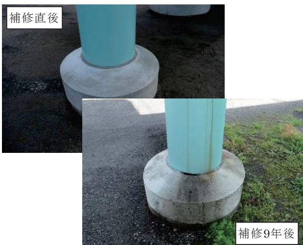
写真-8 支柱基部補修後の状況
