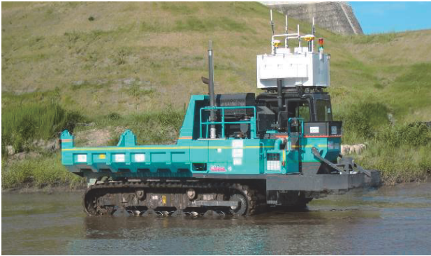
写真-8 半水中部を自律走行するクローラダンプ
