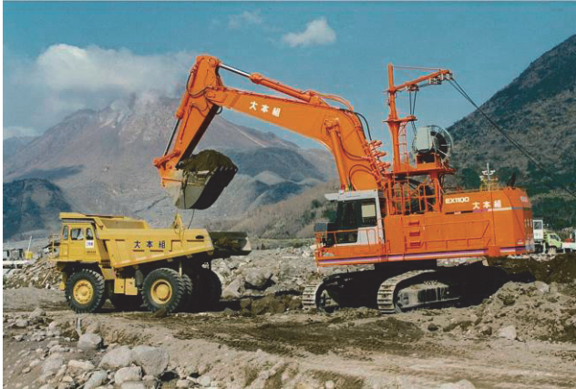
写真-2 初代無人化施工技術による除石作業 (平成6年3月)
