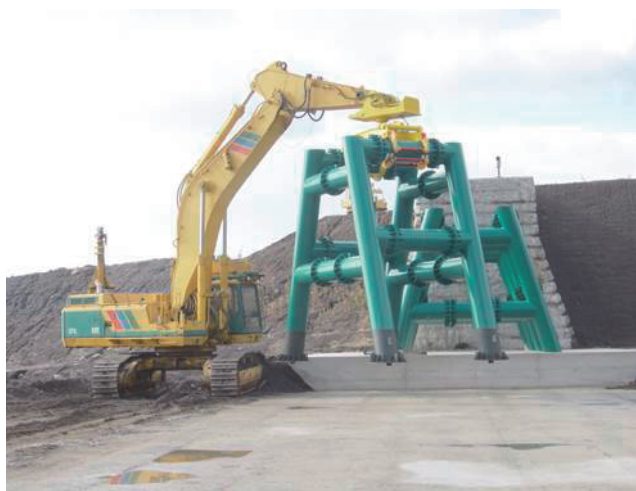
写真-4 鋼製スリット設置状況
