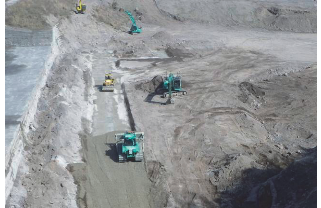
写真-3 RCCコンクリート打設状況 (平成30年3月)
