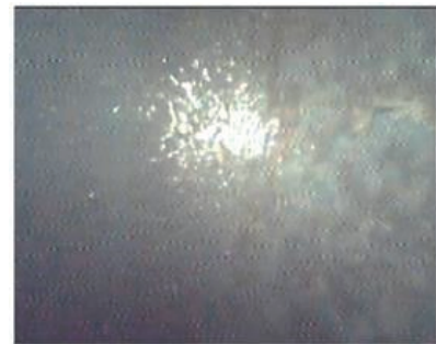
写真-2 非腐食推定箇所の状況(異常なし)
