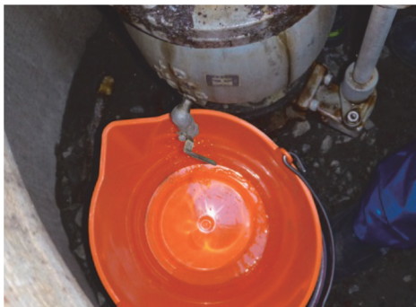
写真-3 空気弁確認状況
