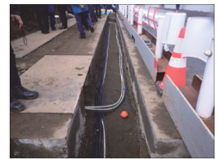
図-6 直接埋設方式 (東京都板橋区における実証実験)
