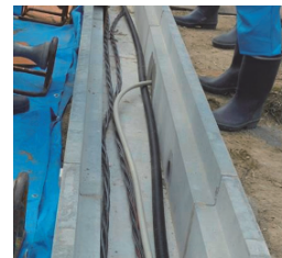
図-5 小型ボックス埋設方式 (新潟県見附市)
