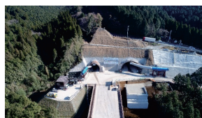
写真-2 二重峠トンネル
