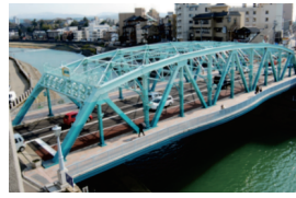
写真-3 犀川大橋
