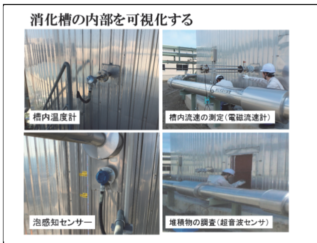
写真-3 消化槽内を可視化する計測器
