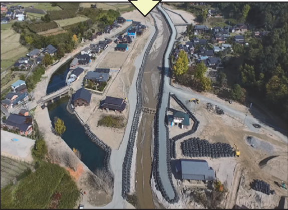
写真-4 赤谷川の応急復旧状況
