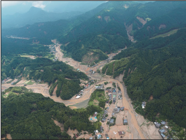
写真-1 山腹崩壊が多発した赤谷川流域
