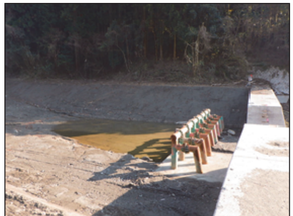
写真-6 除石完了の小河内川砂防堰堤
