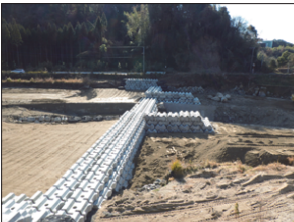
写真-5 赤谷川2号土砂止め工(仮設)
