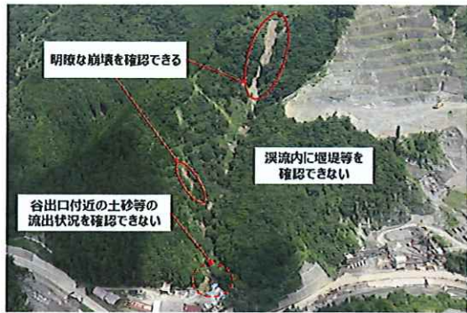
写真-1 危険度Bと判断した土石流危険渓流
