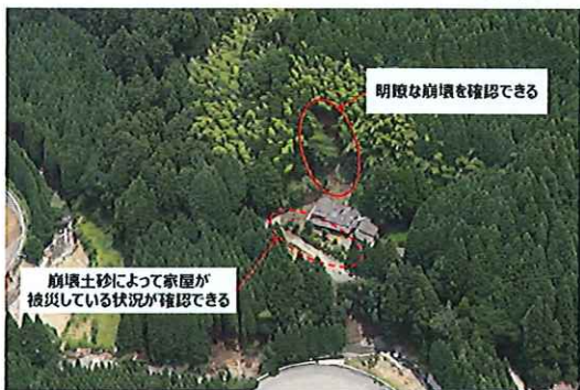
写真-2 危険度Aと判断した急傾斜地崩壊危険箇所
