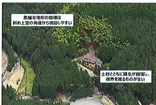
写真・4 急傾斜地崩壊危険箇所の点検時における特徴
