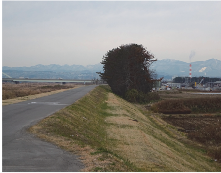
写真-5 堤内地の裏法尻の樹林帯
