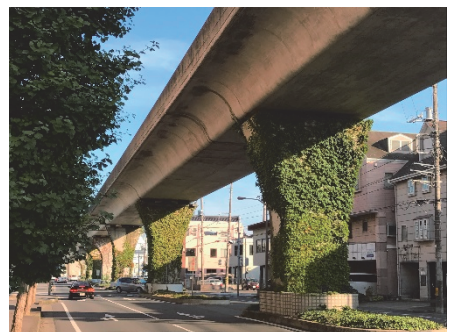
写真-8 高架橋の橋脚の緑化：コンクリート橋脚
