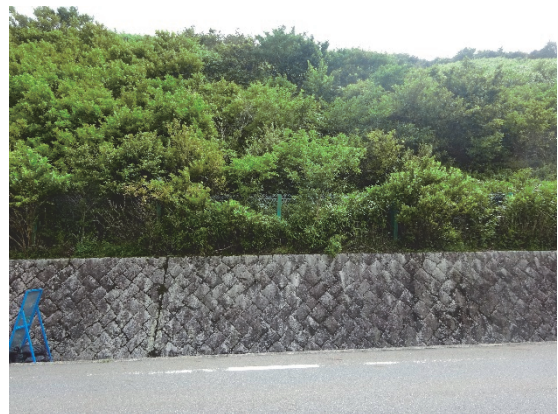
写真-1 植生で被覆された自然斜面
