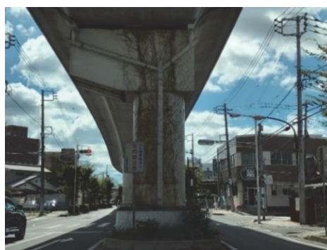
写真-9 ツタを除去した鋼製橋脚（左：全景、右：基部拡大）
