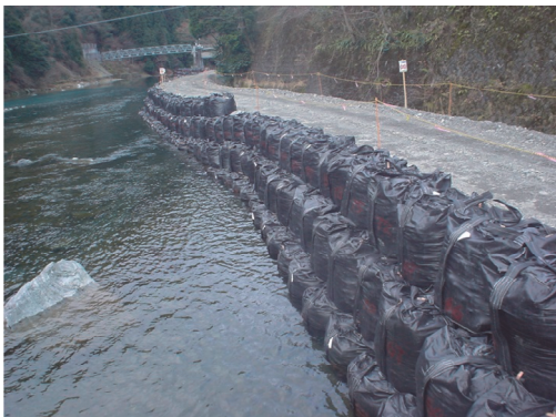
写真-1 工事用仮設道路への適用例
