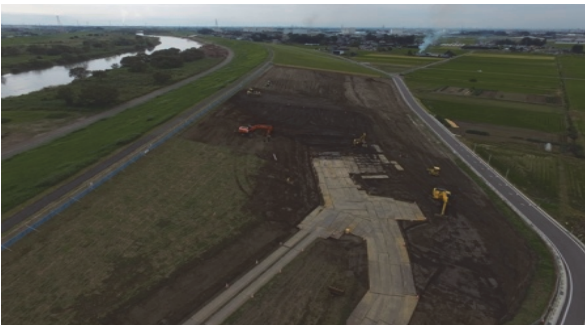
写真-3 上段盛土工事施工時（出水期施工）
