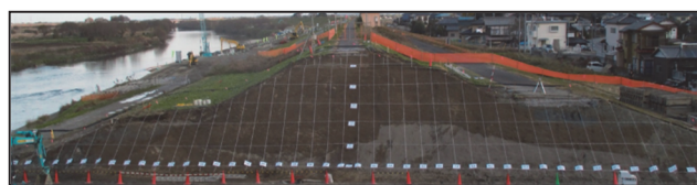
写真-1 堤防開削調査の断面状況（写真左右反転）
