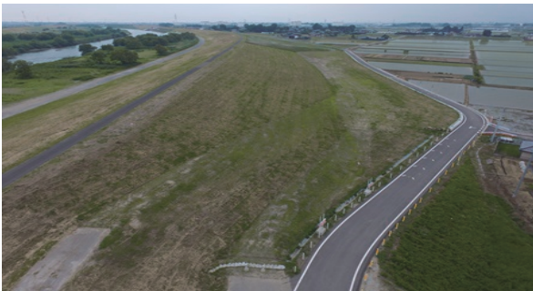
写真-2 基盤工事及び下段盛土(1:4.4)工事完了
