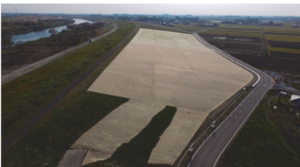
写真-4 堤防強化対策完了(1:7)
