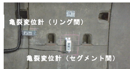
写真-3 計測機器設置状況 (Bトンネル・側壁部)
