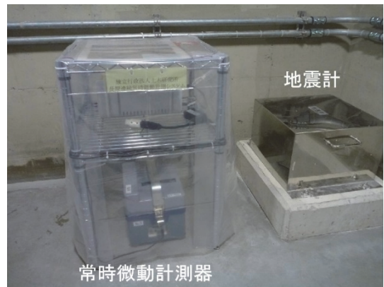
図-6 ダム堤体内での常時微動計測状況
