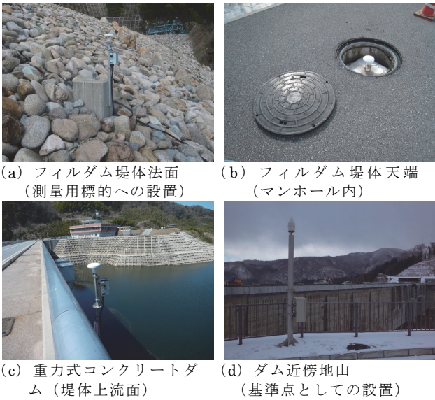
写真-1 ダム堤体変位計測用GPS受信器の設置例
