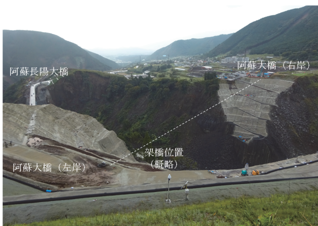
写真-12 阿蘇大橋の架け替え位置の状況
