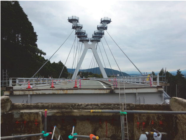
写真-9 A2橋台：胸壁・翼壁の再構築
