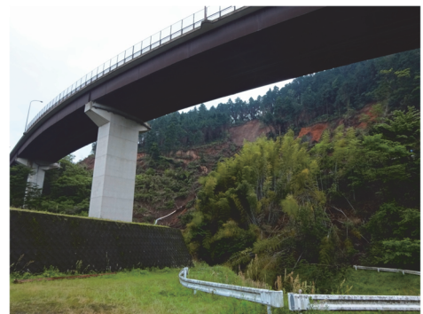
写真-8 斜面崩壊の影響を免れた橋梁
