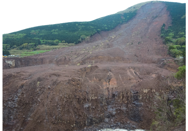
写真-10 本震による斜面崩壊：2016年5月7日時点
