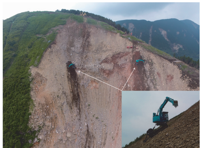
写真-11 急勾配斜面での無人化施工：マシンは水平保持/熊本復興事務所の提供に加筆
