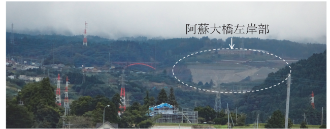
写真-13 阿蘇大橋の左岸斜面の遠望：大津町瀬田から
