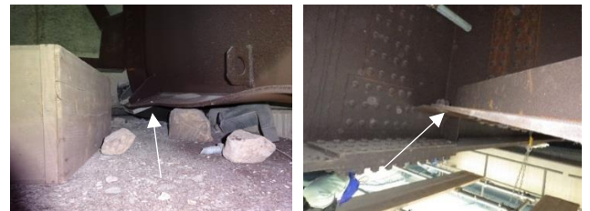
(c) 主桁下フランジの変形 (d) ガセット板の変形
