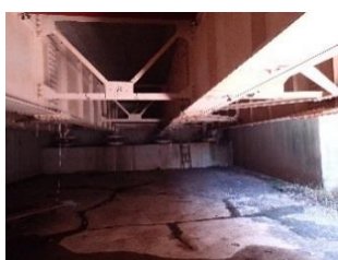
写真-2 桁下状況
