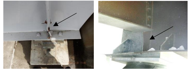
(a) 支点上垂直補剛材の変形1 (b) 支点上垂直補剛材の変形2
