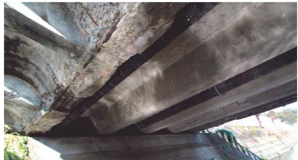
写真-2 主桁の劣化状況
