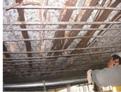
写真-1 既設PC橋におけるPC鋼材の腐食・破断の事例（下床版下面をはつり劣化部を露出させた状況）
