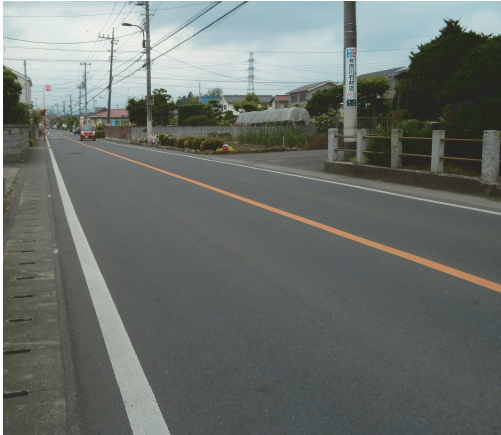
写真-1 施工現場
