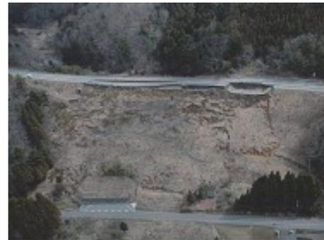
写真-1 地震による道路盛土の崩壊
