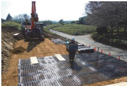
(a) 嵩上げ盛土底面の補強材敷設
