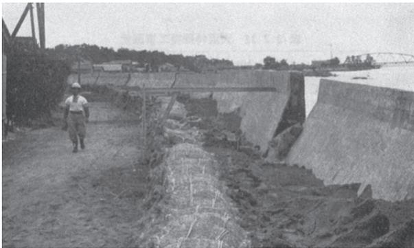
写真-2 新潟地震における特殊堤の被災状況
