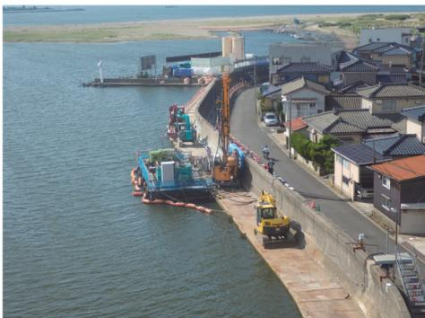
写真-5 フロート式台船を使用した施工状況
