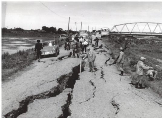
写真-1 新潟地震における土堤の被災状況
