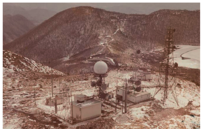
図-3 旧建設省関東地方建設局赤城山レーダ雨量計第1号機(1976年)
