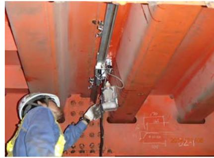
写真-6 超音波探傷試験実施状況
