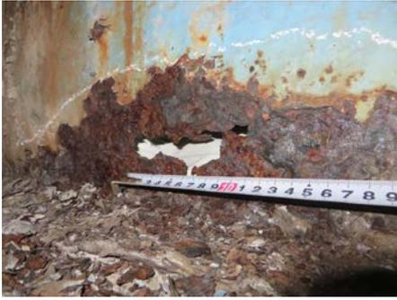
写真-5 橋面等からの漏水による桁端部の腐食 (H26点検、補修済み)
