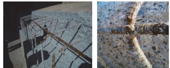
図-1 ASRによる鉄筋破断の例
