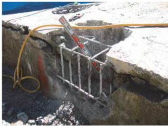
図-2 フーチングのASR損傷例
