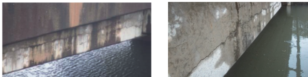
図-7 桁側面のひび割れ状況
