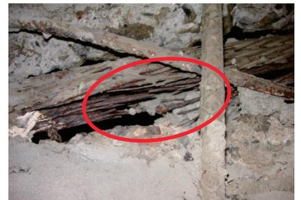
写真-1 内部鋼材の腐食・破断
