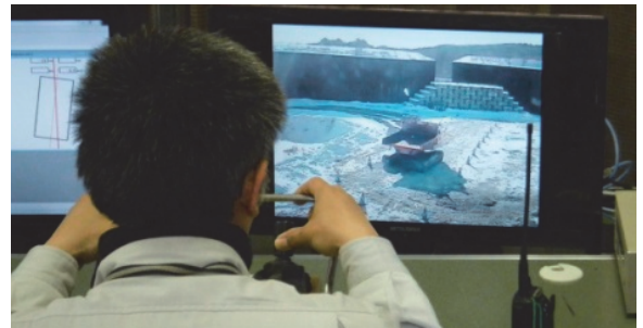
写真-1 カメラ映像による遠隔運転
