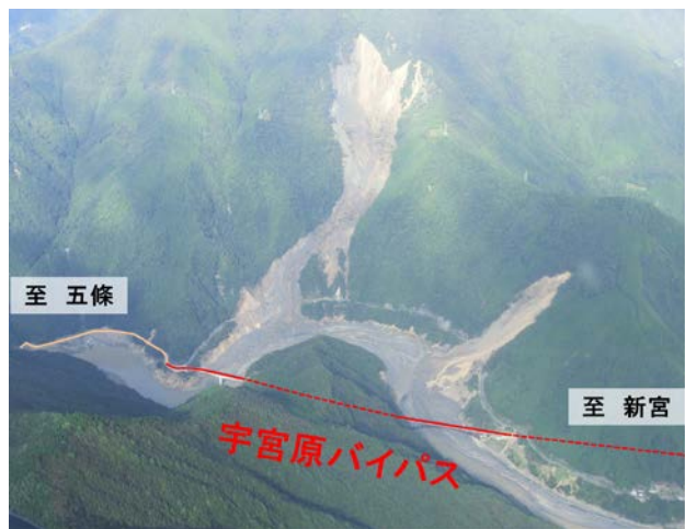
図-5 宇宮原バイパスとその周辺の被災状況
