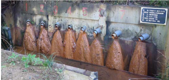
写真-1 現地試験を実施した横ボーリング
