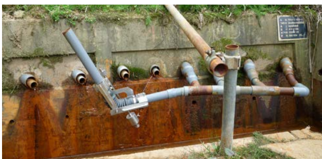
写真-2 集水管閉塞防止器
