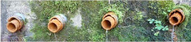
写真-6 集水管閉塞防止器を装着した集水管
