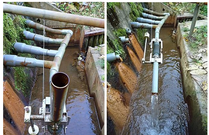
写真-4 集水管閉塞防止器孔口の状況
