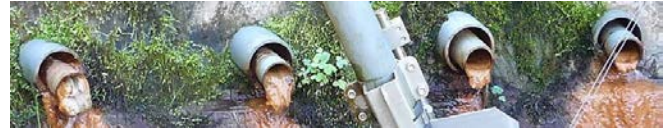
写真-3 集水管閉塞防止器を装着していない集水管
