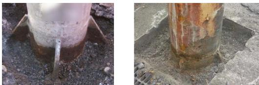
図-7 路面境界での腐食状態の例（左：アスファルトに覆われている場合、右：コンクリートで覆われている場合）
