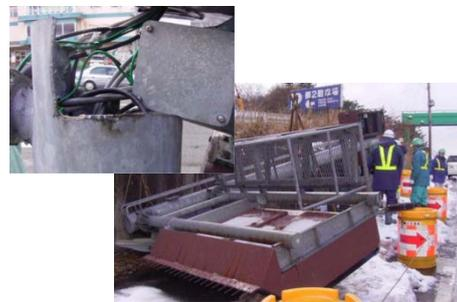
図-2 開口部が破断し倒壊した事例
